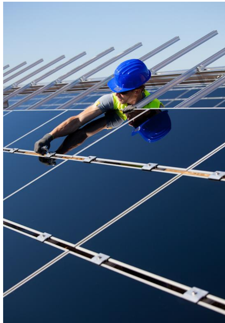
Remplacement de module (crédit photo EDF Renouvelables)
