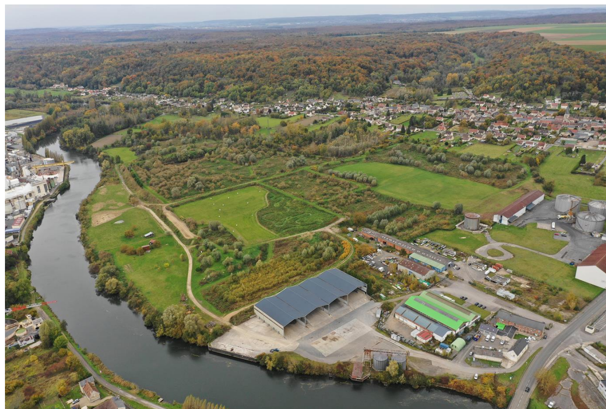
Le site de Berneuil-sur-Aisne est situé au droit d'anciens bassins de décantation d'une sucrerie
