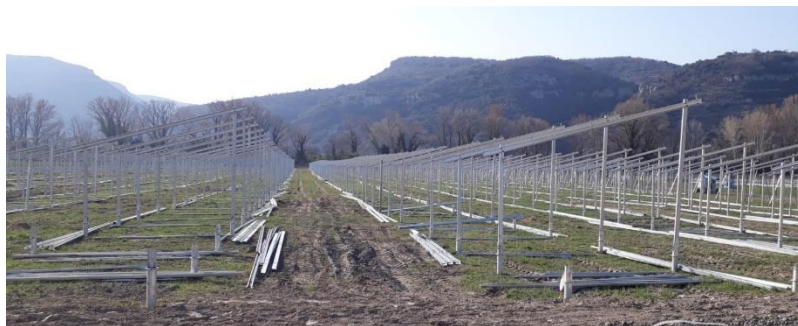
Exemple de structures et fondations par pieux en acier (source : EDF Renouvelables)
