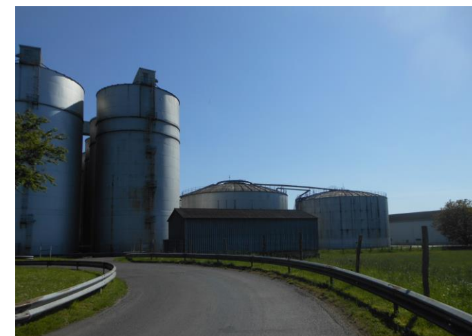
Usine Tereos située à proximité immédiate de l'AEI -Source : ©IDE Environnement, juin 2021
